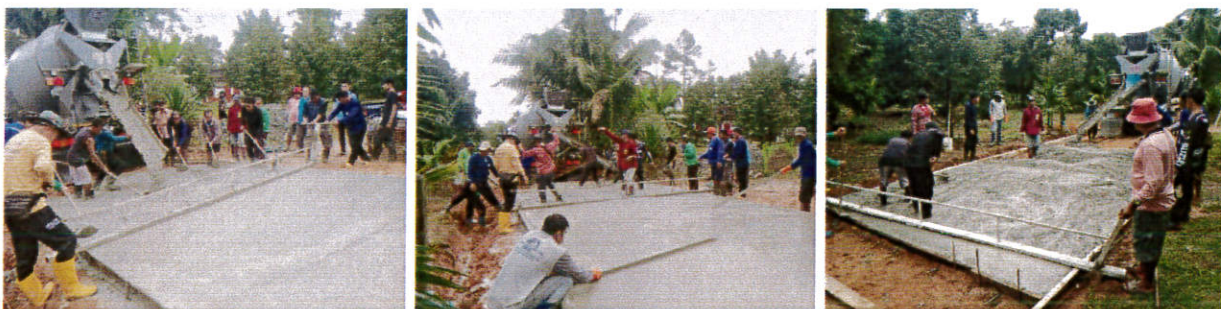
โครงการก่อสร้างถนนคอนกรีตเสริมเหล็ก ซอยสองพี่น้อง หมู่ที่ ๑ บ้านตกชี
