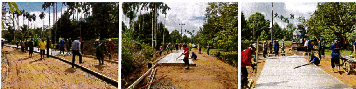
โครงการก่อสร้างถนนคอนกรีตเสริมเหล็ก ซอยอ่างเอ็ด ๑ หมู่ที่ ๖ บ้านอ่างเอ็ด
